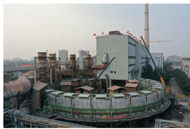
提高水槽的耐腐蚀性能,延长了下水槽的使用寿命;为 715 平方米环冷机"量身定做"的宽踏面的支承辊和回转体支撑轨道,能够有效的减小表面接触应力,更好地适应环冷机热态膨胀;首次采用了新式回转体结构,使台车翻转更为灵活可靠,检修更为便捷;改进了上密封水槽
