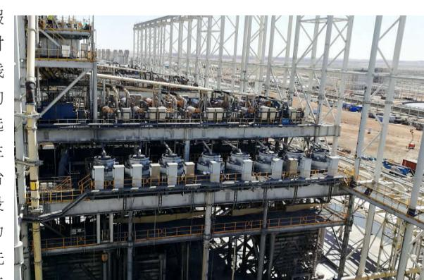
项目采用三维手段进行设计,并进行碰撞检查,工艺专业对三维模型进行二次检查,保证设计质量;设备基础采用模块化设计,方便运输和安装,降低现场安装成本并缩短安装周期;工艺方案经济合理、施工简单、钢材用量少。此外,项目为在线改造项目,为了不影响正常生产,设计方案中新旧系
