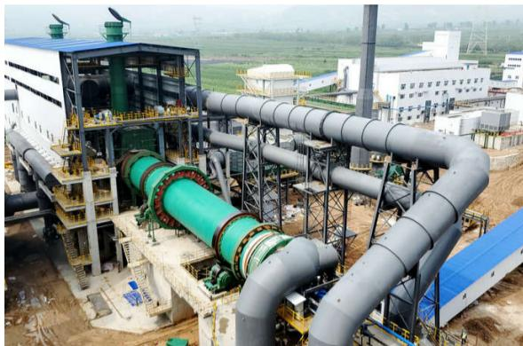
度合作,项目的建设积极响应了国家“绿色、高效、可持续”的发展方针,应用的链箅机-回转窑技术代表绿色、高效球团的发展方向。从合同签订到开工建设到点火烘炉再
